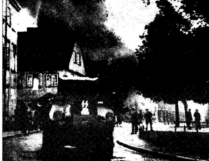
Plonący budynek Poczty Polskiej w Gdańsku
