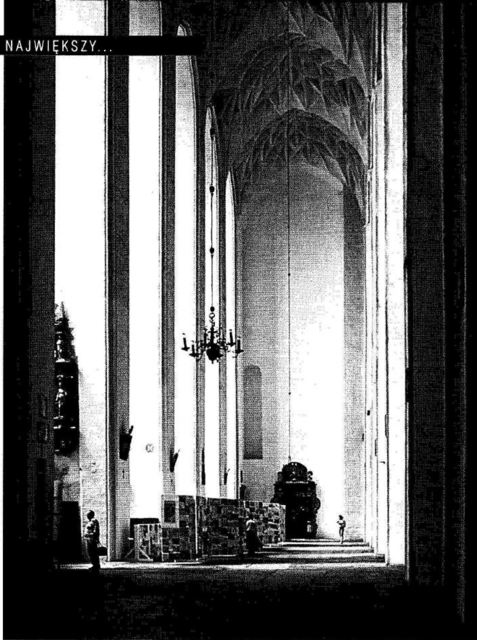
Przypory schowane wewnątrz świątyni tworzą jej boczne kaplice
