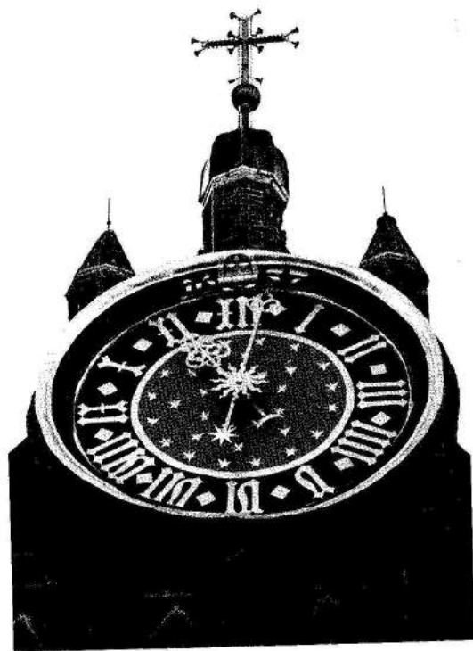
17. Zegar groblowy na ścianie zewnętrznej kościoła
